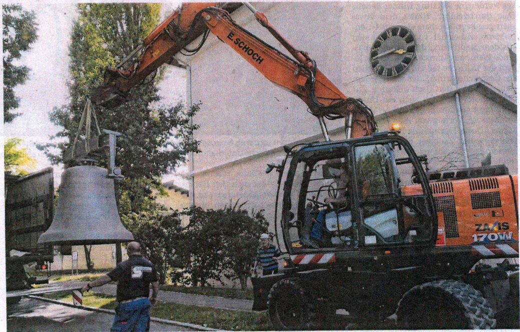
Die rund 3,9 Tonnen schwere Glocke hängt erfolgreich am Haken vor dem Turmuhrenmagazin und wird dann vorsichtig auf den neuen Bestimmungsort neben der Glocke „Hoffnung“ abgeladen und aufgestellt. Foto: Iris Frey
